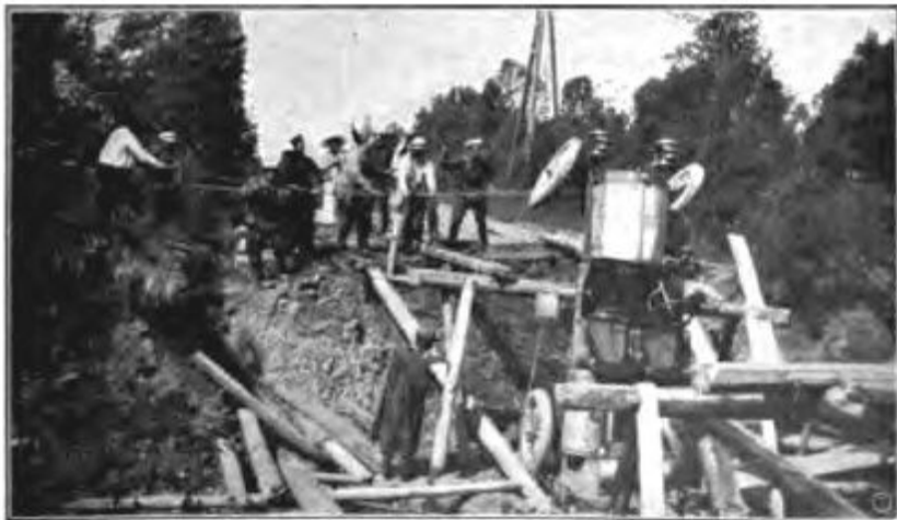
Salvataggio dell'automobile travolta dal crollo di un ponte.
