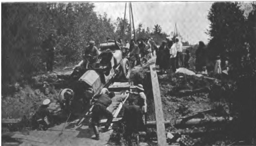
L'Italia tratta in salvo dopo essere stata travolta dal crollo d'un ponte nella Transbaikalia.
