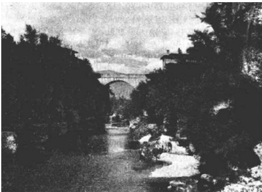
Fig. 18 a . — Lo storico ponte di S. Quirino.
