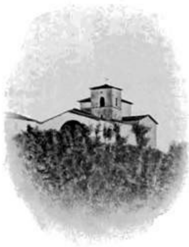
BARGA (DINTORNI) — TIGLIO DI SOPRA.
