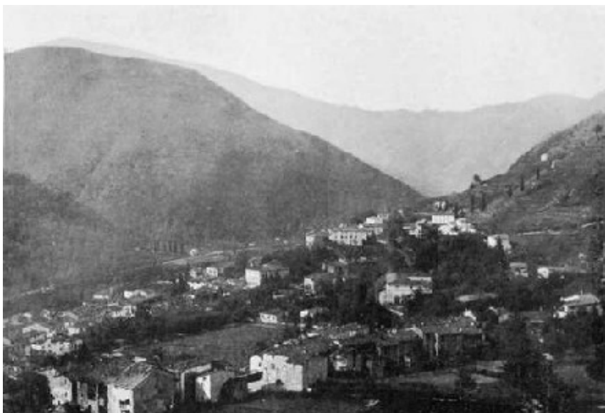
CORSENA E BAGNO ALLA VILLA.
