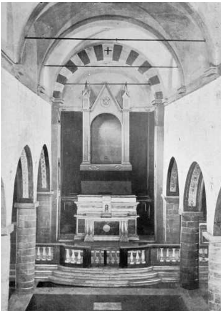
CORSENA — CHIESA DI S. PIETRO: INTERNO. (Fot. Pellegrini).
