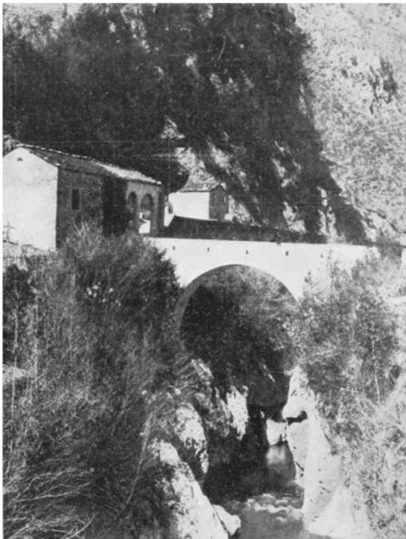
BAGNI DI LUCCA — PONTE NERO. (Fot. Pellegrini).
