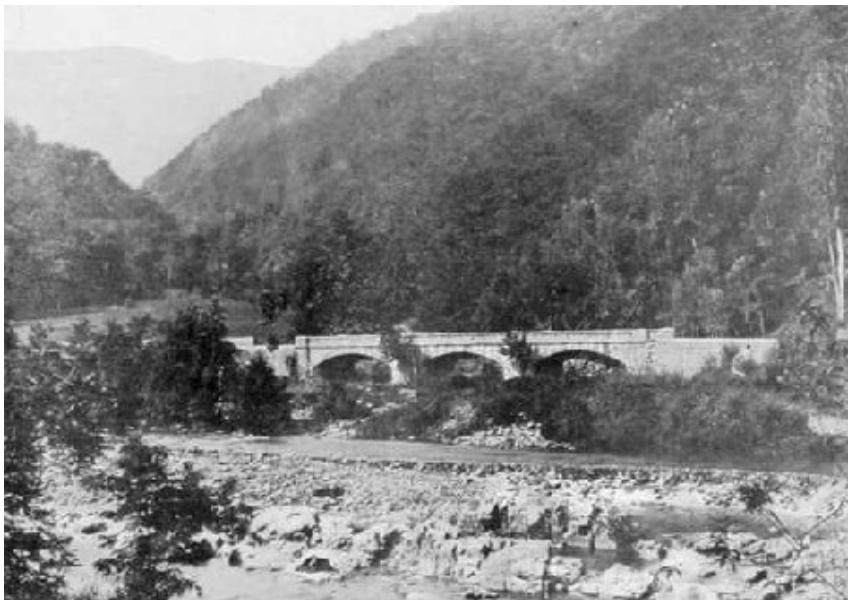
BAGNI DI LUCCA — PONTE SULLA BULIESIMA, DETTO PONTE CONTE DI TORINO.
