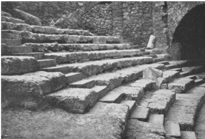
TEATRO ANTICO — PARTE CENTRALE DELLA CAVEA. (Fot. Grita).
