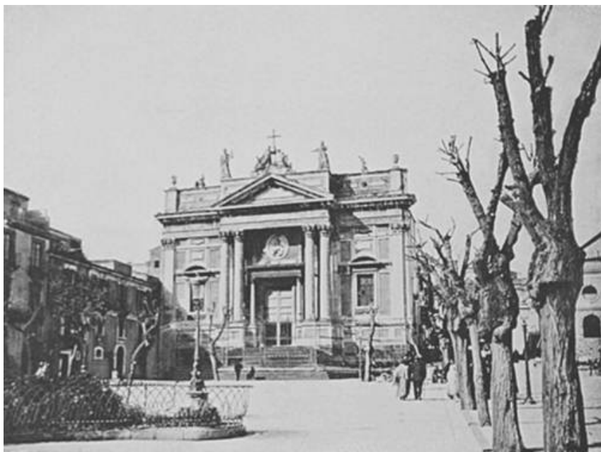
SANT'AGATA ALLA FORNACE. (Fot. Martinez).
