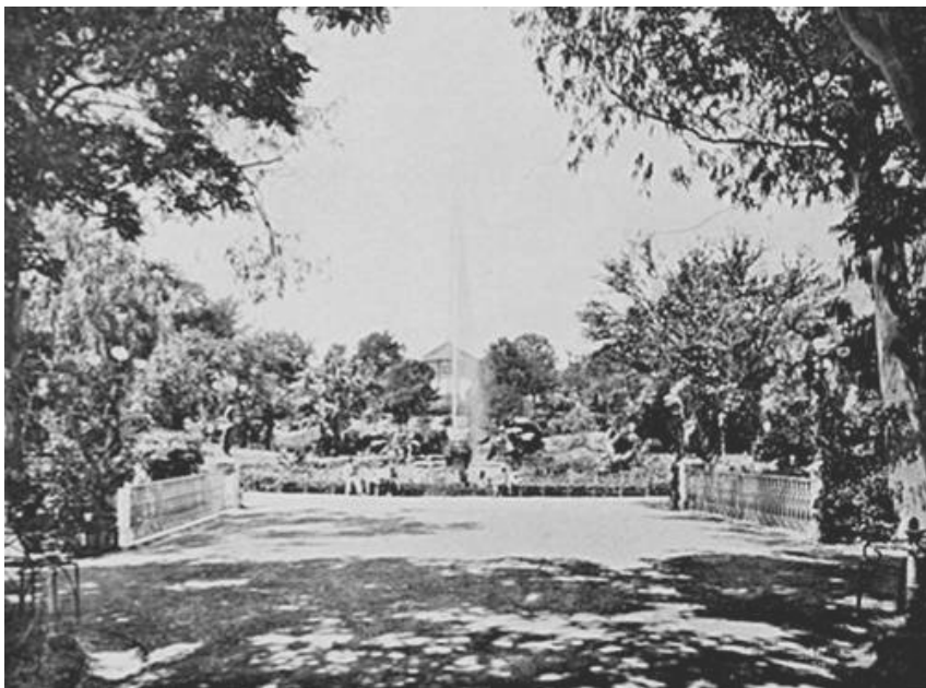
L'INGRESSO DELLA VILLA BELLINI. (Fot. Alinari).
