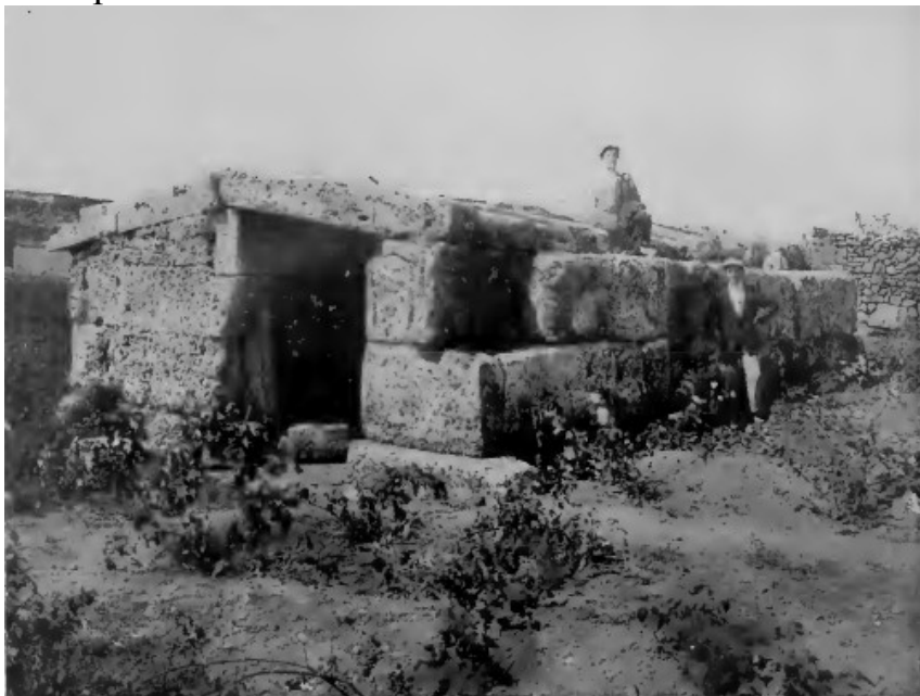
Fig. 106 – Edificio a grandi blocchi – PATÙ.
