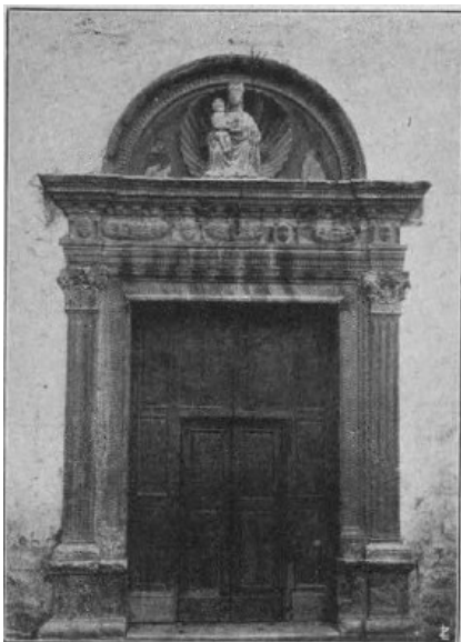
Porta principale della chiesa di S. Domenico.
