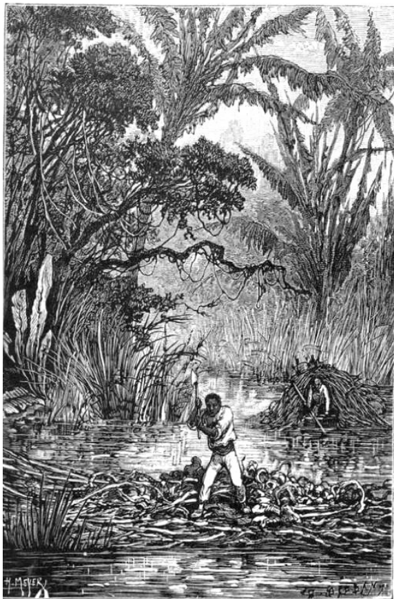
La diga aveva ceduto
