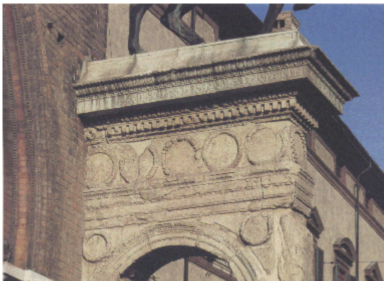
Basamento della statua equestre a Niccolò III d'Este. Dettaglio dell'inserimento di un suo lato nella parete della facciata del palazzo Comunale di Ferrara.
