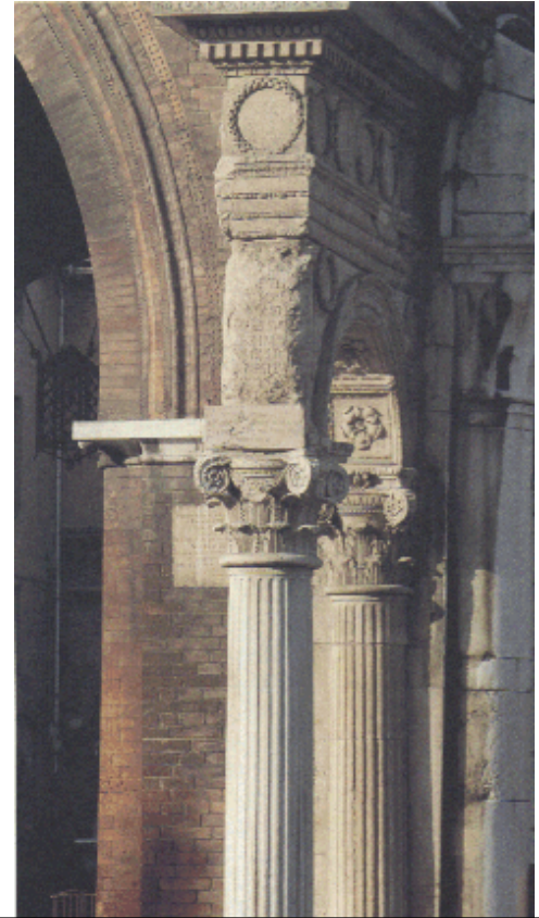
Basamento della statua di Niccolò III d'Este, con raffronto delle colonne e dei capitelli (part.). «Arco del
