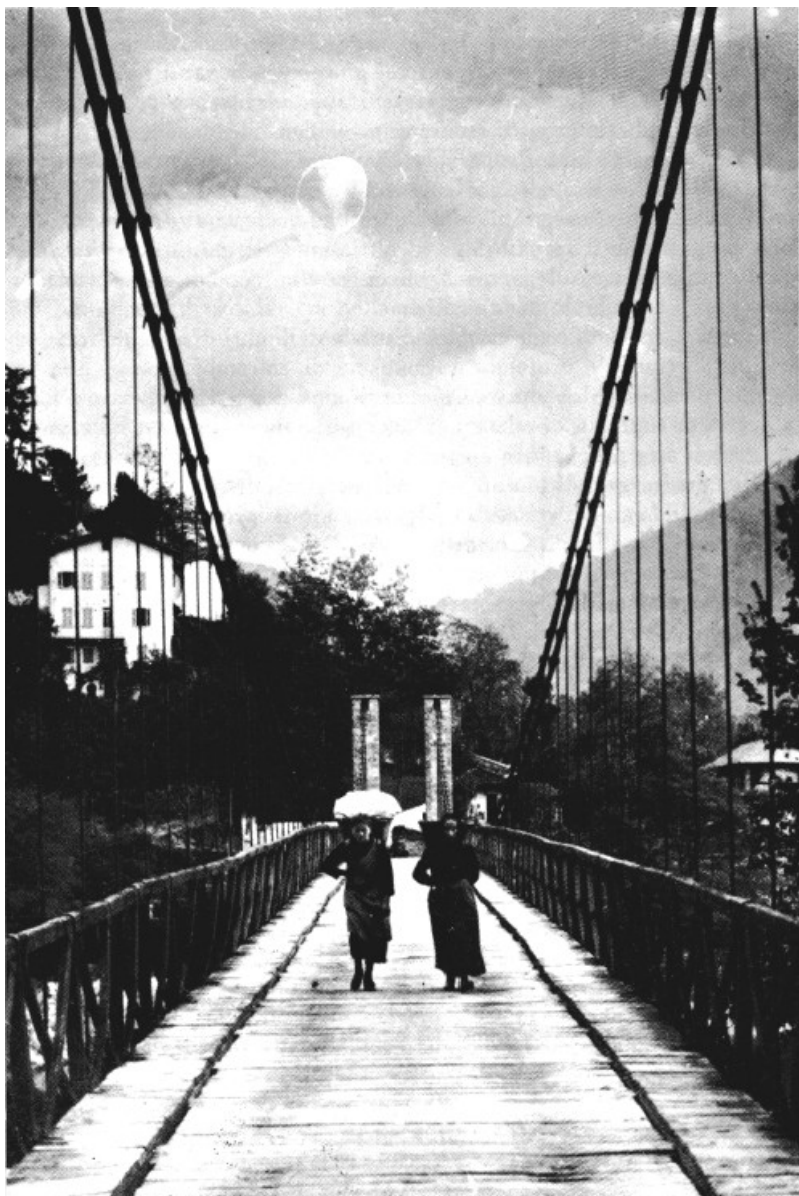
Il vecchio ponte pensile di Crevola demolito nel 1957.
